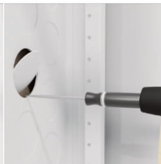
3. Utblokking til rør
